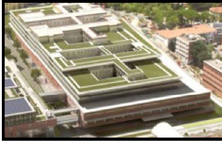
Figure I - 20 : Les toitures végétalisées de la clinique Paul -Pierre Riquet
