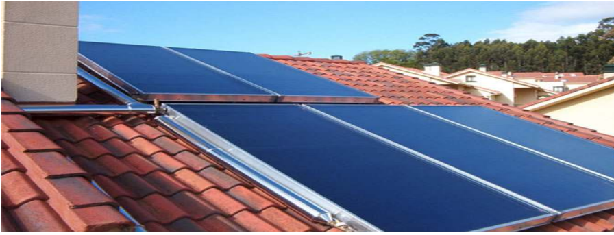
Figure V - 1 : capteur solaire plan
