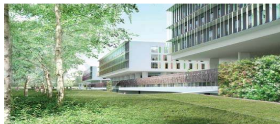
Figure I - 24 : un écran végétal dans le côté sud ouest
