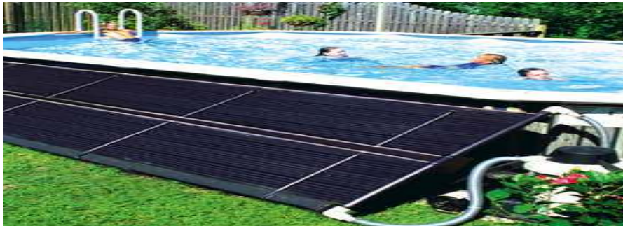
Figure V - 2 : capteur non vitré
