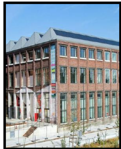
Figure 78 : Photo perspective illustre le Bâtiment de stockage de laine du Champ Libre
