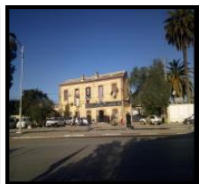
Figure 167 : La gare ferroviaire.
