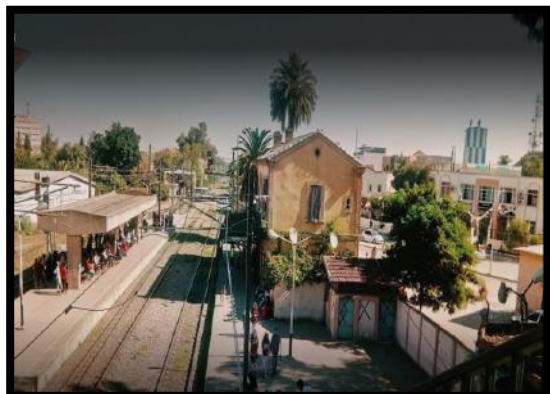
Figure 133 : La gare ferroviaire de Beni Mered.
