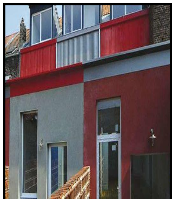
Figure 80: L'îlot Stephenson après la réhabilitation
