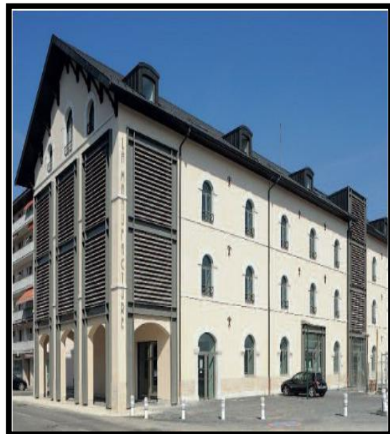
Figure 101 : photo perspective illustre de manufacture fait un tabac après la rénovation
