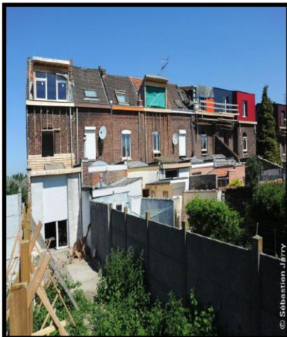
Figure 79: L'îlot Stephenson avant la réhabilitation
