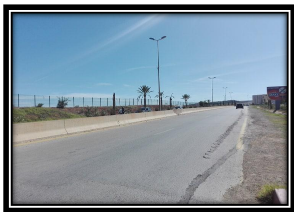
Figure 3.11 : l'absence du trottoir
