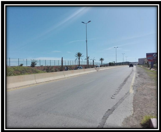
Figure 3.24 : absence du trottoir Source : les auteures. 17/10/2019
