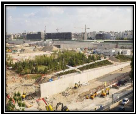
Figure2.20 : avant la réalisation
