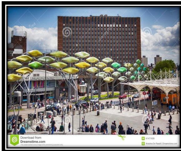
Figure2.41 : Centre commercial de Stratford Centre depuis
