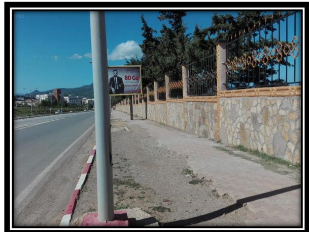
Figure 3.25 : mur de cloture autour du parc Source : les auteures. 17/10/2019
