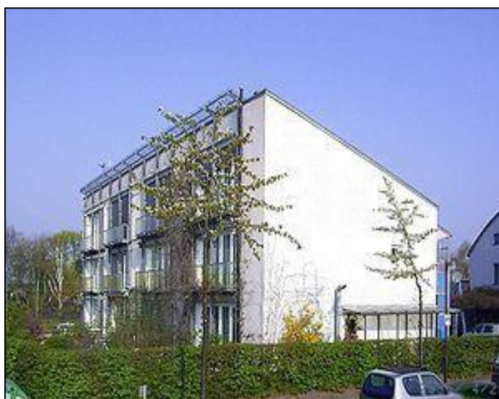
Figure 5 : maison passive a damsta dt. en Allemagne
