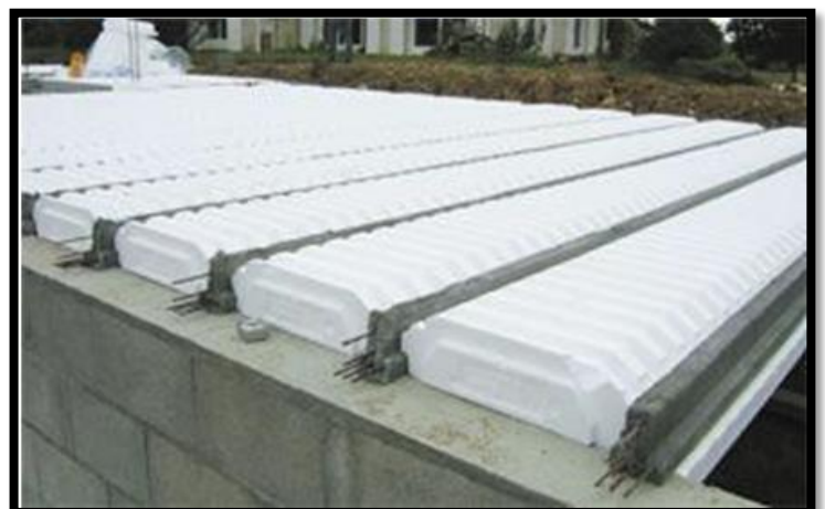
Figure104: dalle corps creux avec hourdis en polystyrène
