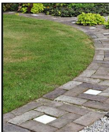
Figure 122 : Le pavé drainé dans le terrain Source : pintrest.com
