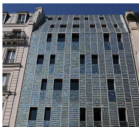
Figure 131 : Panneaux solaire photovoltaïque Source : pinterest.com
