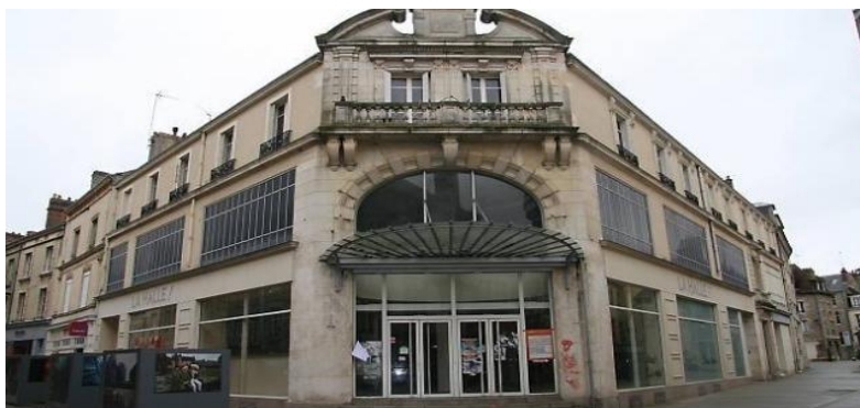
Figure II.8 : Bâtiments commerciaux en friche à Alençon.
