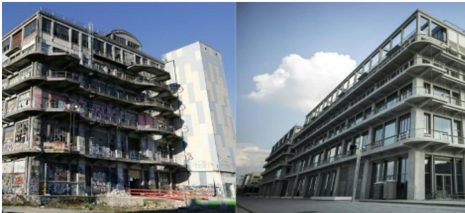
Figure II.13 : la reconversion des anciens magasins généraux de pantin.
