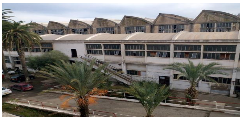
Figure II.3 : Les ateliers de maintenance d'El Hamma.
