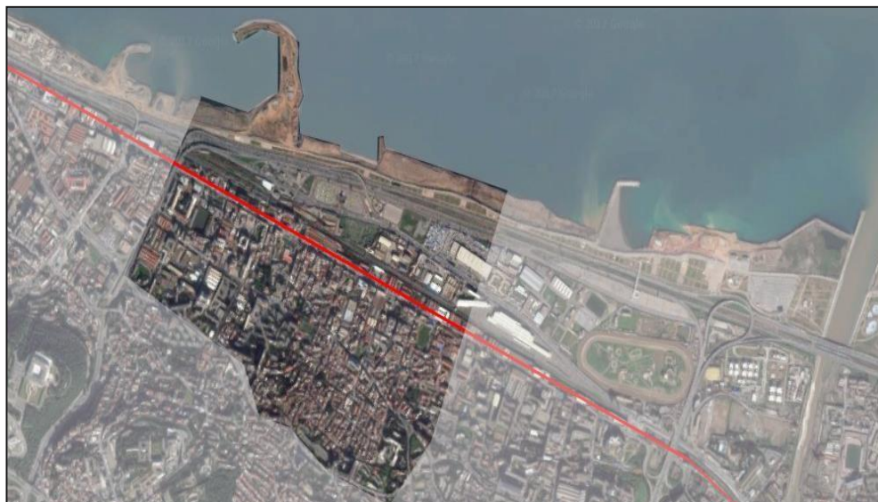
Figure III.7 : Vue aérienne de notre aire d'étude.
