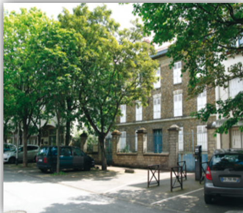
Fig 11 : L'ancienne gendarmerie qui est transformée en un petit logement collectif. (Réhabilitation)
