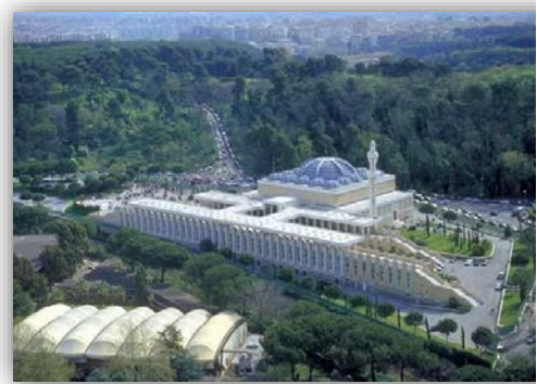
Fig159: Vue aérienne sur le centre culturel islamique de Rome
