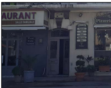
Fig 104 : Ornementation coloniale d'une façade
