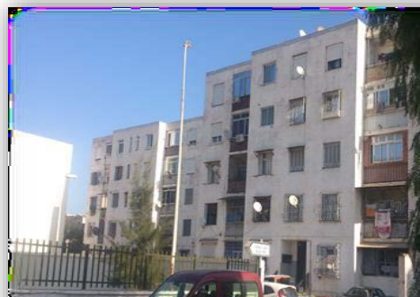
Fig 75 : La cité de l'hôpital 1974 Source : Auteur
