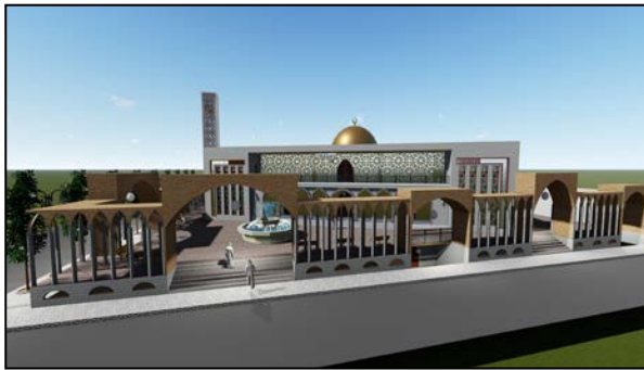
Fig 208 : Façade latérale de la mosquée (l'entrée principale)
