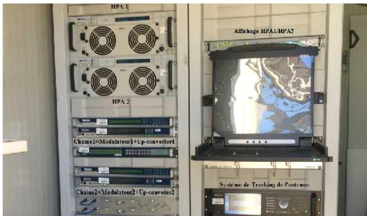
Figure3.10. Matériels utilisés pour calculer le bilan de liaison
