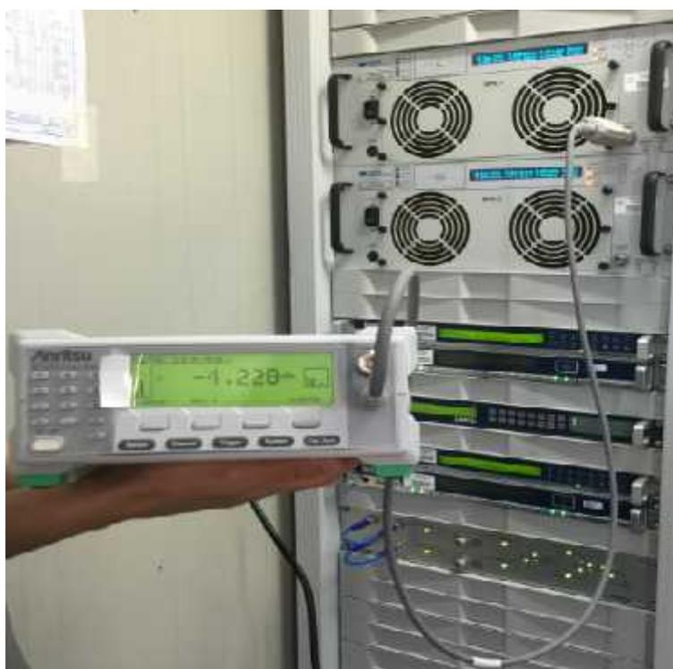
Figure3.11. Procédure de calibrage du puissance-mètre
