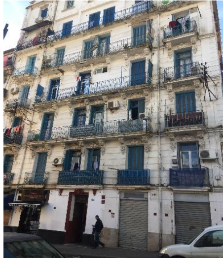
Figure 35. façade bâtiment 03 ilot N° 03
