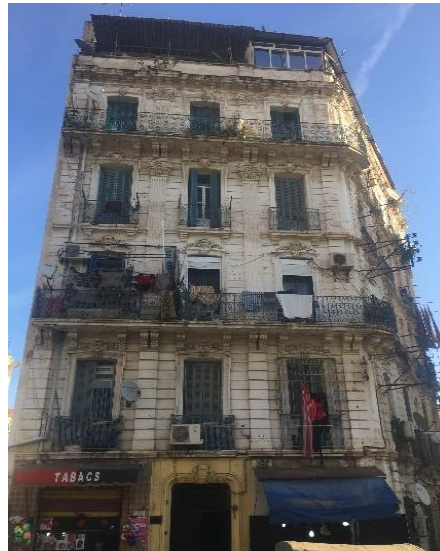
Figure 33. façade du bâtiment 05 Ilot N° 01
