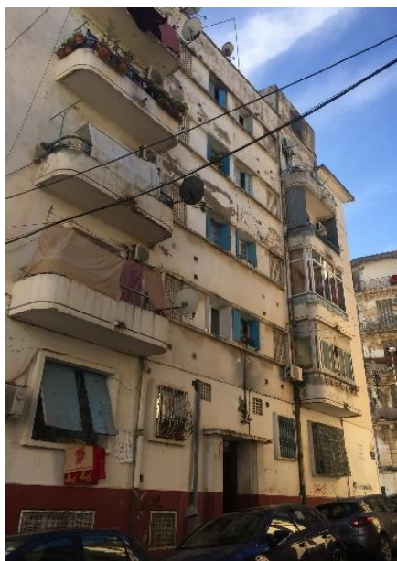
Figure 34. façade du bâtiment 06 ilot N° 01
