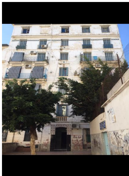
Figure 32. façade du bâtiment 03 ilots N°01
