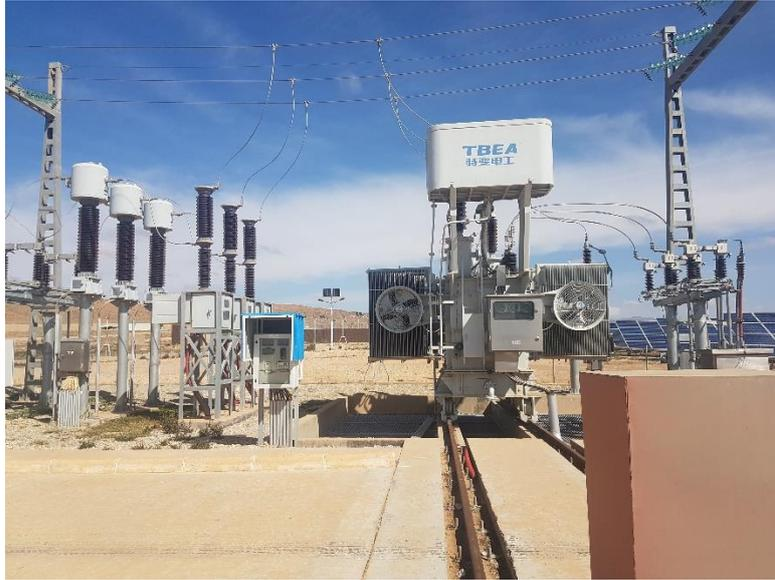
Figure (II-5) : Le transformateur 60 KV.
