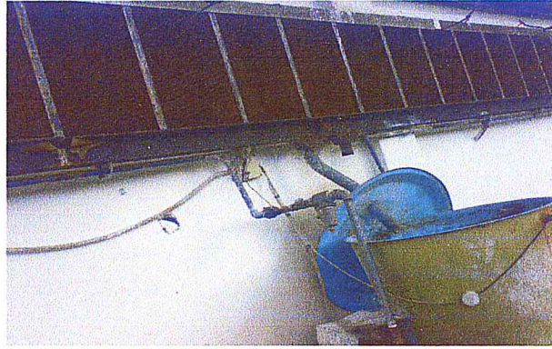
Figure 19 : Système d'humidification (photo personnel 2010)
