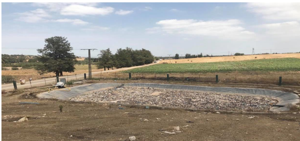
Figure 2.15 : Bassin principale de stockage de lixiviat dans CET AIN ROMANA
