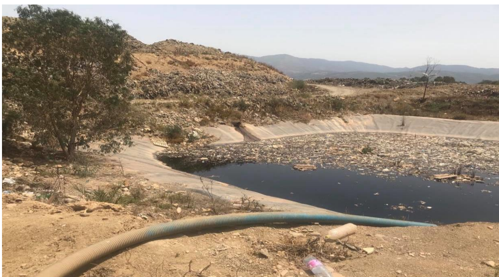
Figure 2.20 : Bassin de lixiviat pour les deux CET (AIN ROMANA et MOUZAIA)
