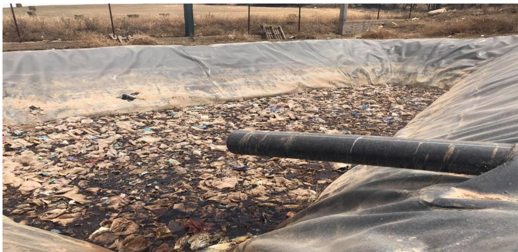
Figure 2.14 : Le bassin de stockage .
