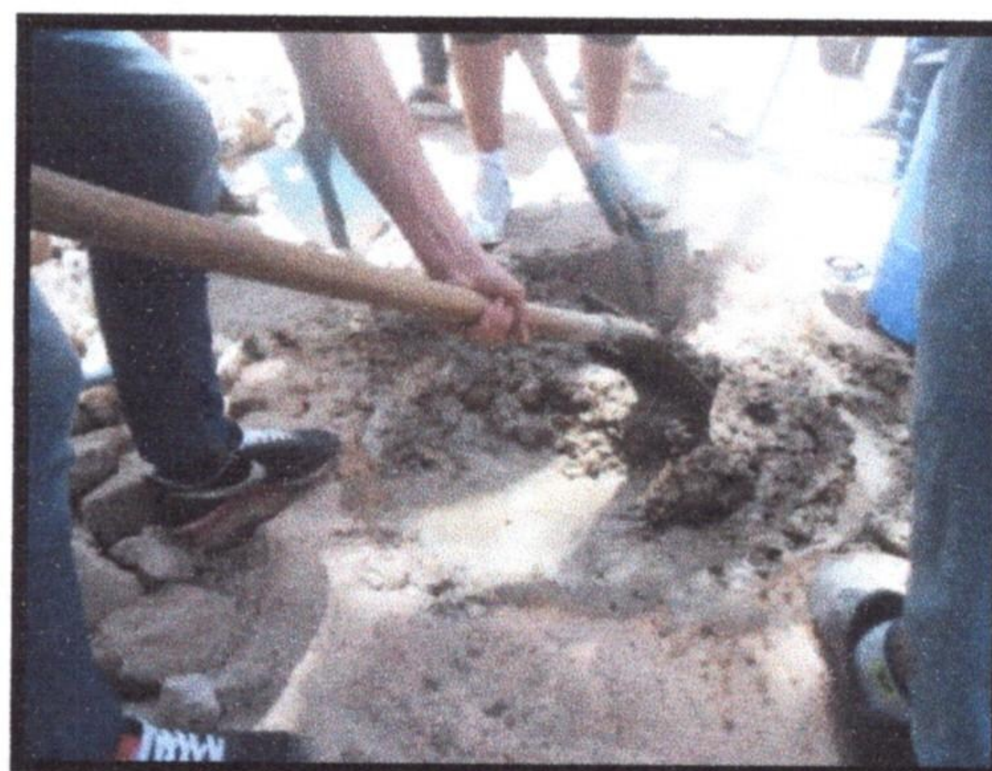
Figure 42 : Mélange D'enduit Source : Auteur
