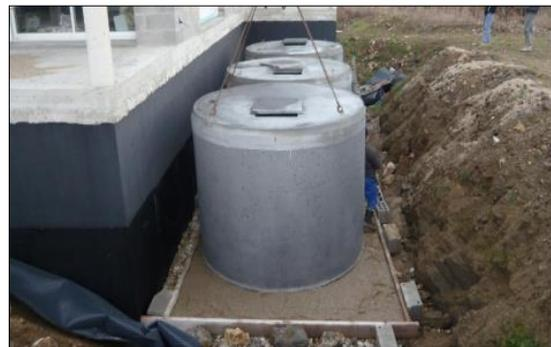
**Figure 13 : cuve de stockage en béton**
