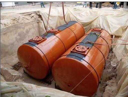
**Figure 15 : cuve de stockage en Acier galvanisé**
