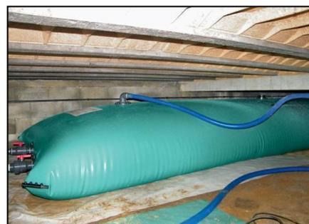
Figure 103 : cuve de stockage installée au sous-sol.
