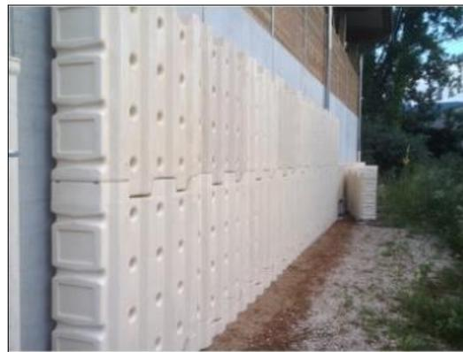
**Figure 14 : cuve de stockage en mur d'eau**
