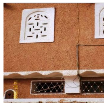
FIGURE 8 : PROTECTION DES OUVERTURES
