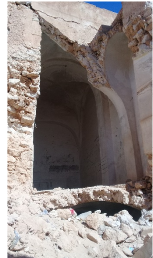
FIGURE : IMPORTANCE DE EPESSEURS DES MURS ET DES PLA NCHERS
