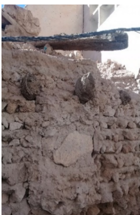
FIGURE : DIFFÉRENTS MATERIAUX ENCEINTE ( PIERRE, TRONC DE PALMIER, TIMCHENTE )
