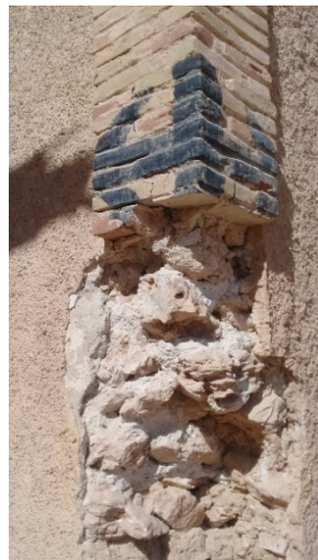
FIGURE : UTILISATION DE LA PIERRE ET LE TIMCHENTE ET LA BRIQUE PLEIN
