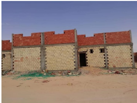
FIGURE 46: UTILISATION DES MATERIAUX NON LOCAUX (LE BRIQUE ET BETON ARME)
