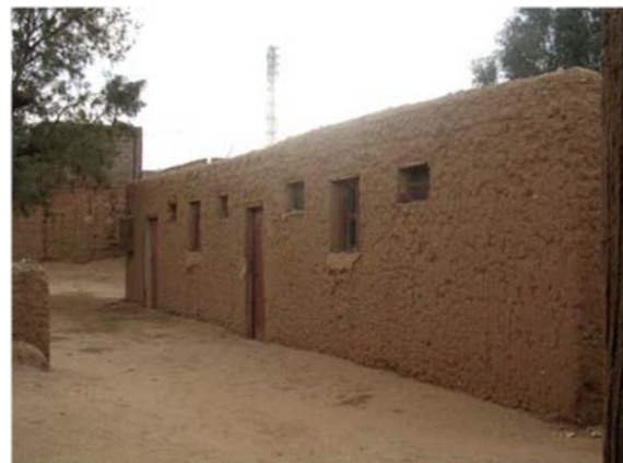
FIGURE 34: VUE DEPUIS LA COUR PRINCIPALE SUR DAR DIAFF
