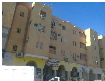
FIGURE : LES FACADES NE CORESPENT PAS AU STYLE ARCHITECTURALE SAHARIENNE
