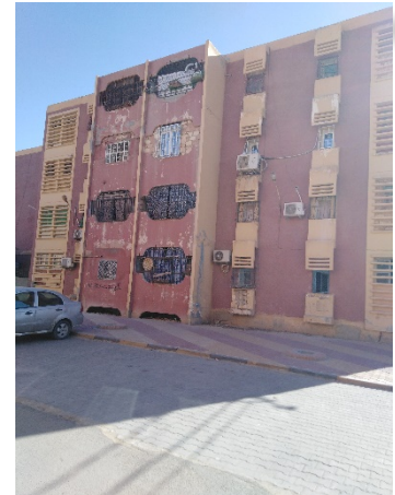
FIGURE : HABITAT COLECTIF A LA VILLE DE TIMACINE CONSTRUCTION DE TYPE NORD
