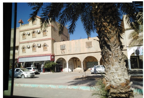
FIGURE 55: VILLAS A OUARGLA Source: prises par l'auteur-Novembre 2019
