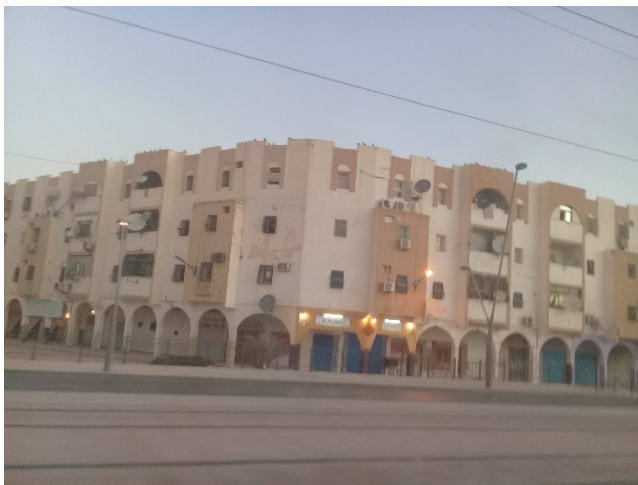
FIGURE 57: FAÇADES D'HABITAT COLLECTIF A OUARGLA CHARGÉES PAR LES SAILLANTS DE CLIMATISEURS
