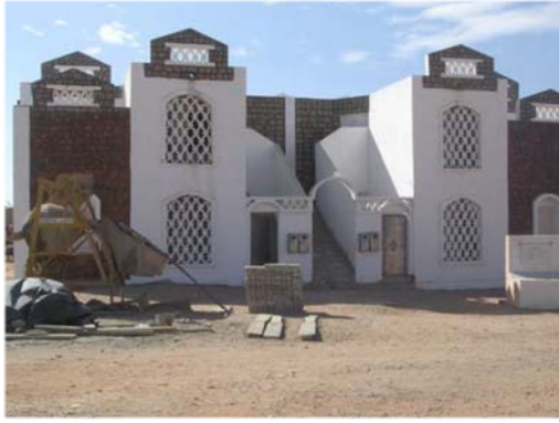
FIGURE 36: PROJET DE LOGEMENTS SOCIAUX EN COURS DE REALISATION, PROJET DE LOGEMENTS SOCIAUX, TIHAGOUINE AL JAZIRA
