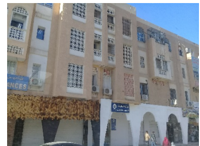
FIGURE : LES GRANDE OUVERTURES ET LES CLIMATISEURS QUI DONNENT SUR LA FACADE
