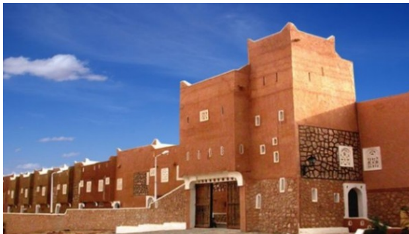
FIGURE 14:LE ENTRE PRINCIPALE DE KSAR TAFILELET
