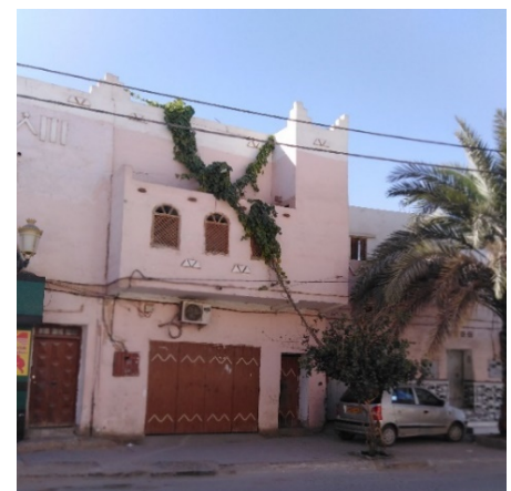
FIGURE 74 : PHOTOS MONTRANT DES FAÇADES RESTAUREES AU KSAR DE OUARGLA Source : prises par l'auteur-Novembre 2019
