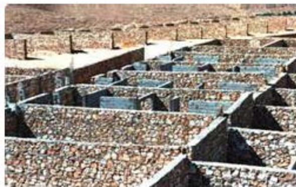
FIGURE 11: MUR PORTEUR EN PIERRE
