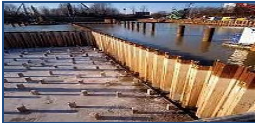
Figure I.14. Dévoilement écrans de palplanches
