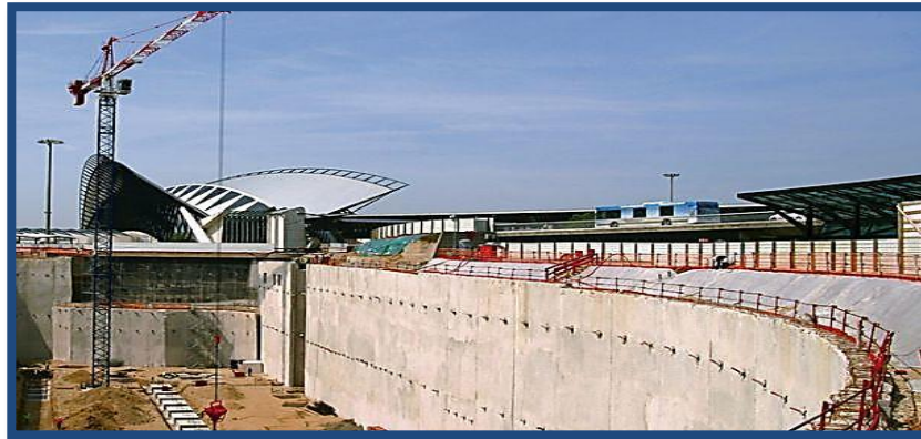
Figure I.4. Paroi moulée réalisée à proximité d'un ouvrage [5]
