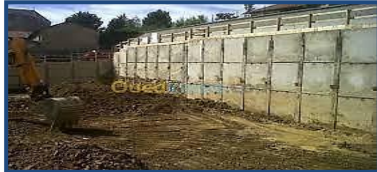
Figure I.6 Paroi Berlinoise se trouvant à Bordj El Bahri (Alger)
