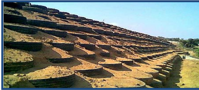
Figure I.11 Chantier expérimental "Mur Pneusol" à Bousmail (Alger)
