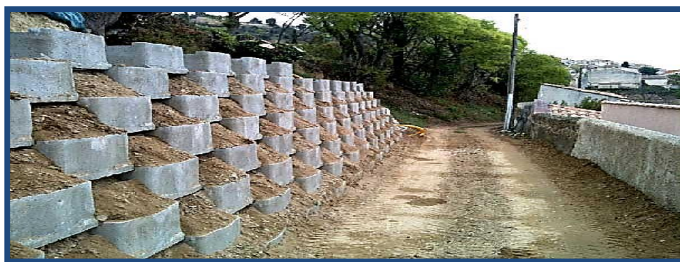
Figure I.10 Mur en gabions rangés (mur paysage)
