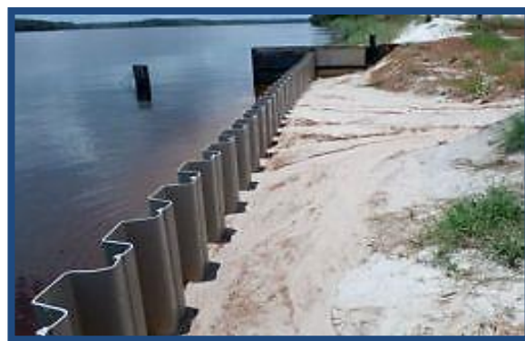
Figure I.8 Ecran en palplanches métalliques
