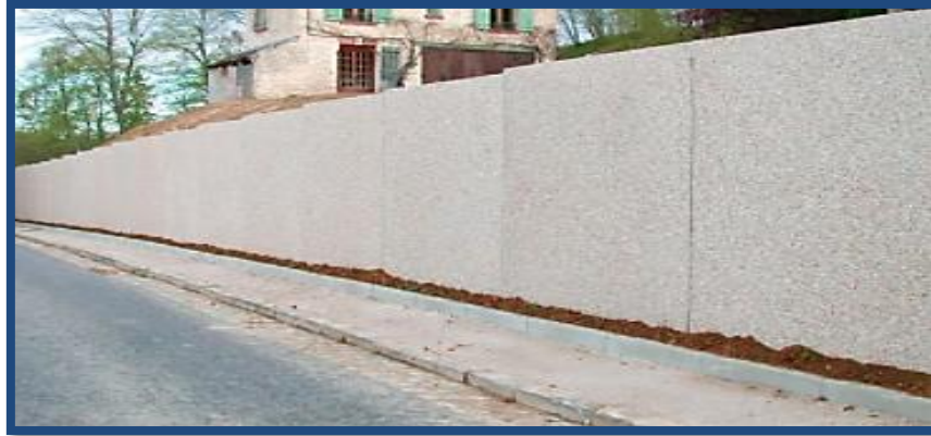
Figure I.2 Vue de mur en béton armé [16]
