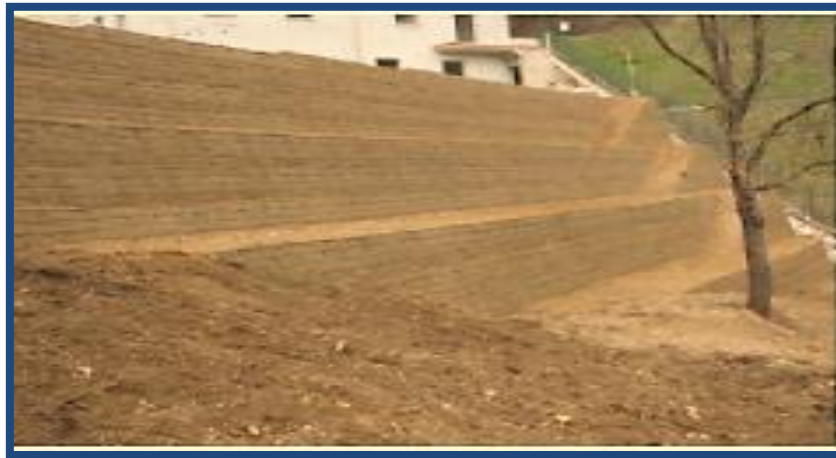
Figure I.3 : Exemple de mur en sol renforcé [16]
