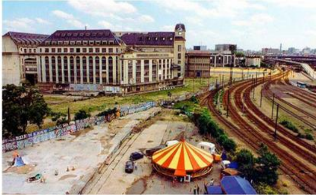
Figure 45: Les Grands Moulins à gauche avant les travaux du début du chantier de la ZAC.
