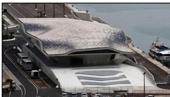
Photo 89 : Détail de la couverture de la gare
