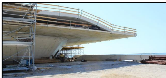
Photo 88 : Détail de la structure de la gare
