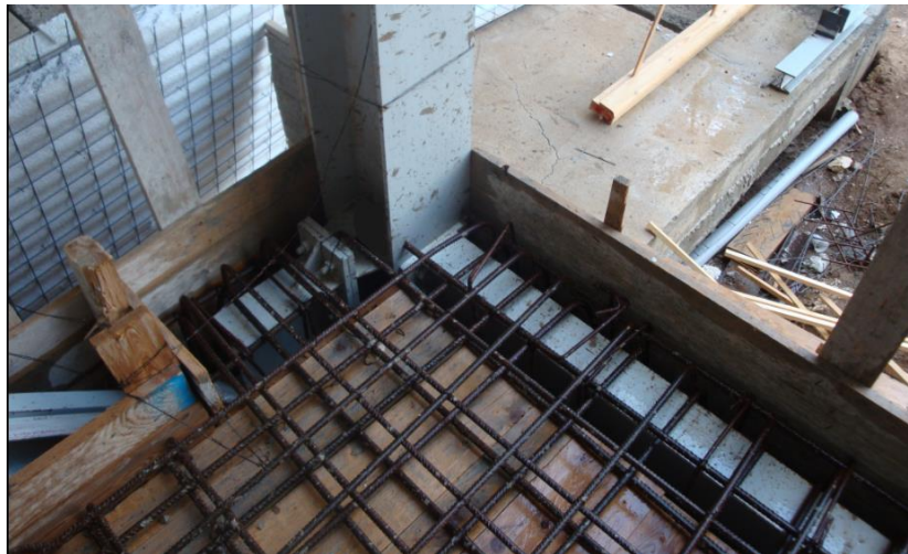
Figure 4. 14: relier de l'armateur sur les consoles.
