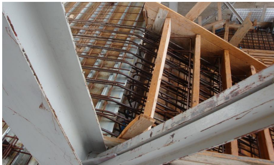
Figure 4. 17: les relier de l'armateur sur les poutres et les solives.
