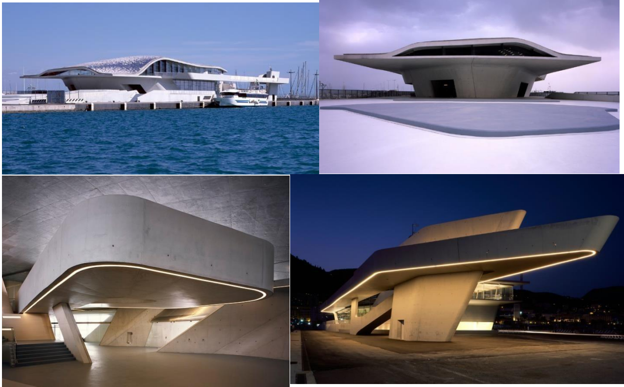
Fig 29: vue sur la gare maritime Salerno de l'extérieur et de l'intérieur
