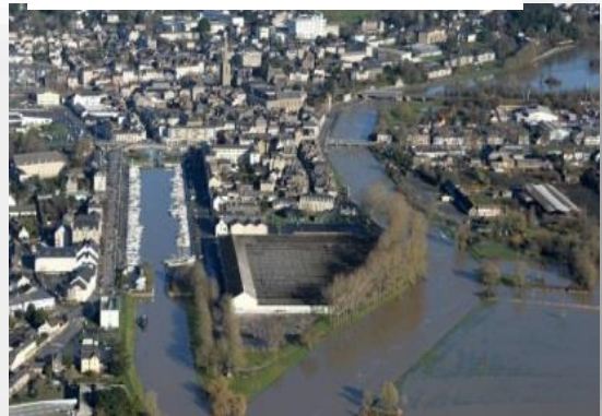
Figure 1 : Remontée des eaux
