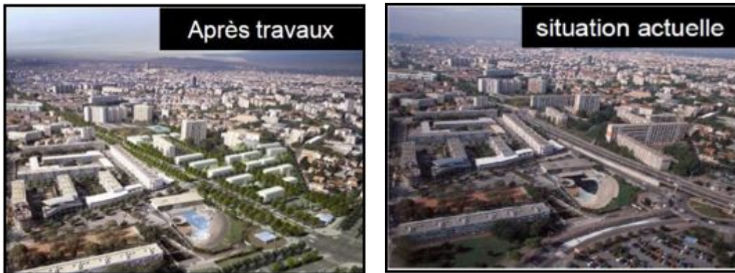
Fig 37 Avant et après les travaux
