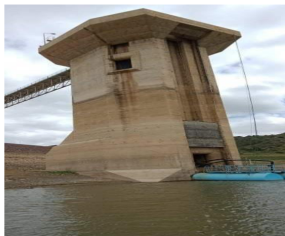
Figure 3 : à coté de station de pompage
