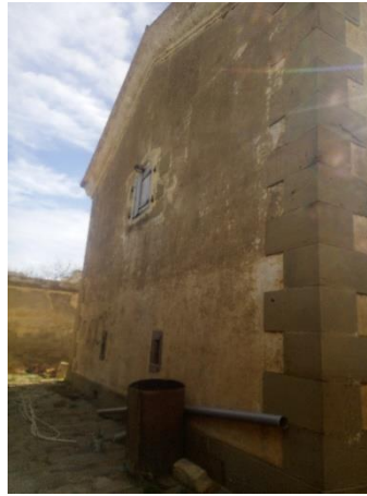
Fig. 122 vue extérieure de la fenêtre
