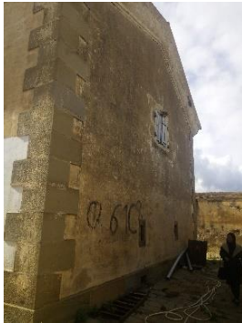
Fig. 108 fenêtre en bois de la poudrière
