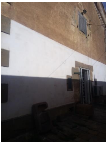
Fig. 11 la porte d'entrée de la poudrière
