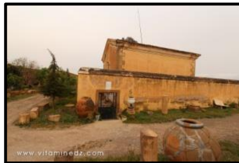
Figure77 : L'enceinte est accessible par une seule porte
