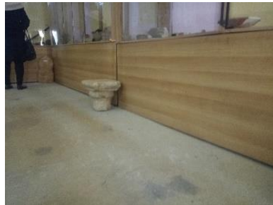
Fig. 131 revêtement de sol à l'intérieur de la poudrière
