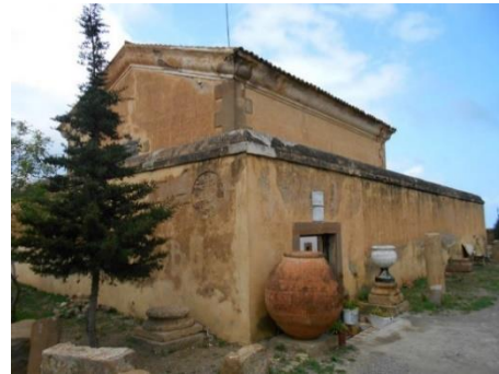
Fig. 119la porte secondaire de la poudrière
