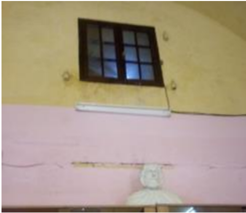
Fig. 121 vue d'intérieure de la fenêtre
