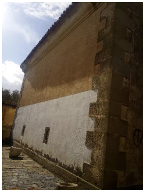
Fig. 106 mur de la poudrière
