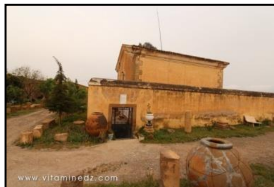
Fig. 45 : vue de la cour de la poudrière.
