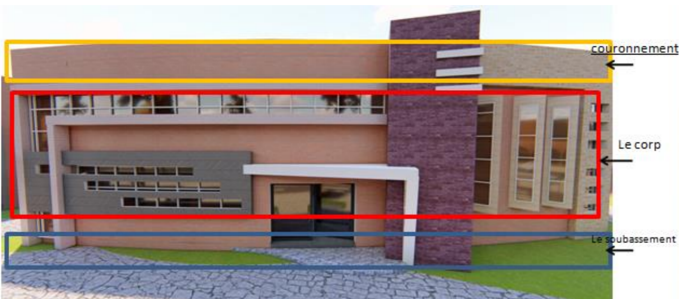
Figure 5.26 : Vue sur façade ouest
