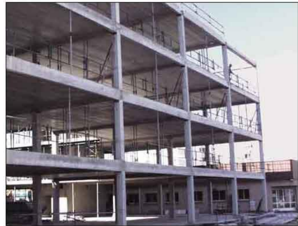
Figure 5.29 : Système structurelle poteau poutre
