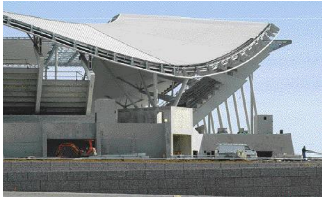
Figure 5.32 : Toiture en charpente métallique
