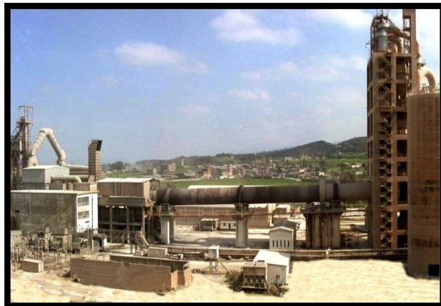
Figure I.11. Ligne de cuisson de cimenterie de Meftah
