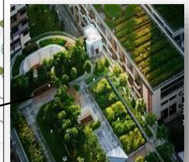
Toit généralisé stockant source : groupeleclerc.ca
