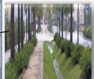
Noue d'infiltration, source : Synthèse des prescriptions de gestion des eaux pluvial 2018
