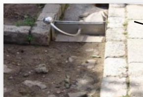
Canaux à ciel ouvert source : PDF gestion des eaux pluviales sur la parcelle printemps 2018
