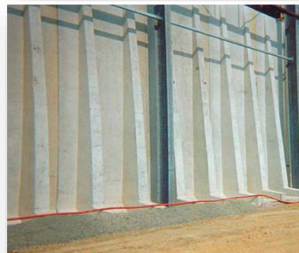
Figure 59 : mur de soutènement en béton
