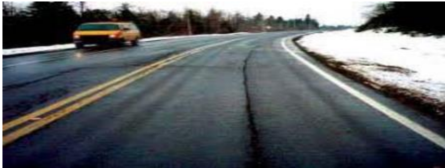
Figure I.16 : Soulèvement différentiel
