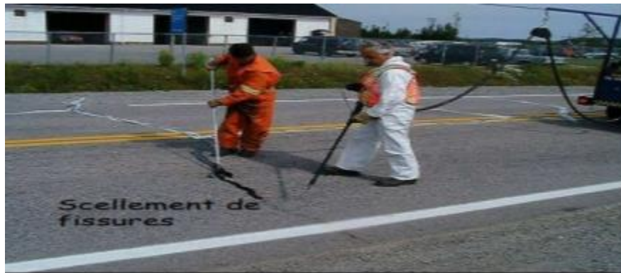
Figure I.31: Travaux de scellement de fissures(10)
