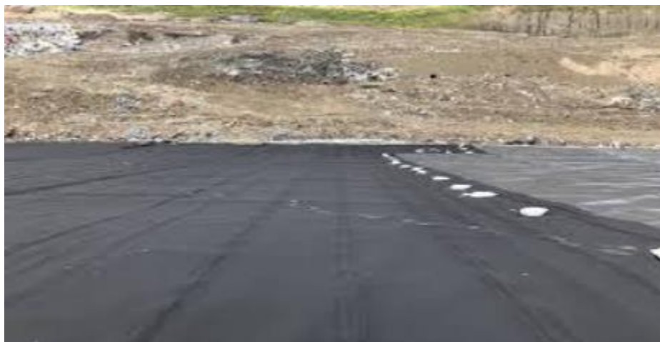
Figure II.8 : Application de géo-composites
