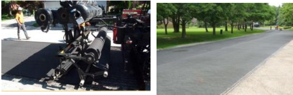
Figure I.34: Pose de la membrane au niveau d'une chaussée(10)
