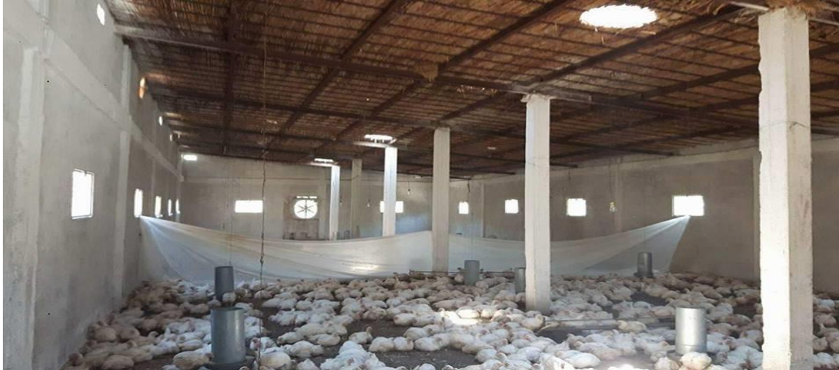
Figure 35 : Les poulets en phase de croissance (photo personnel)
