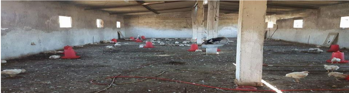
Figure26 : Aération par les fenêtres à la période de printemps (photo personnelle)
