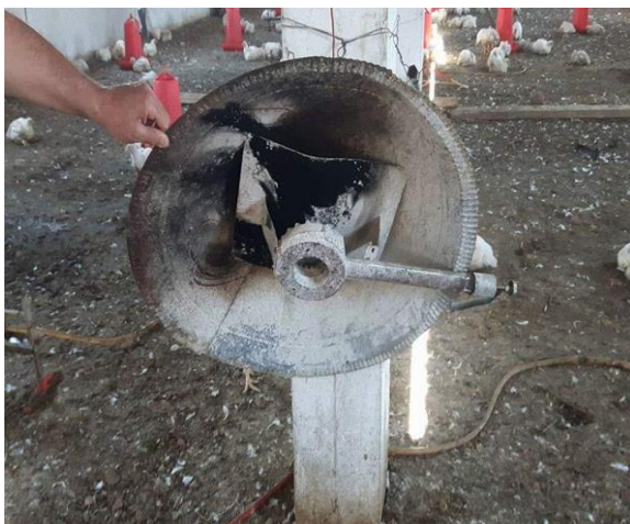
Figure24 : Chauffage par gaz butane
