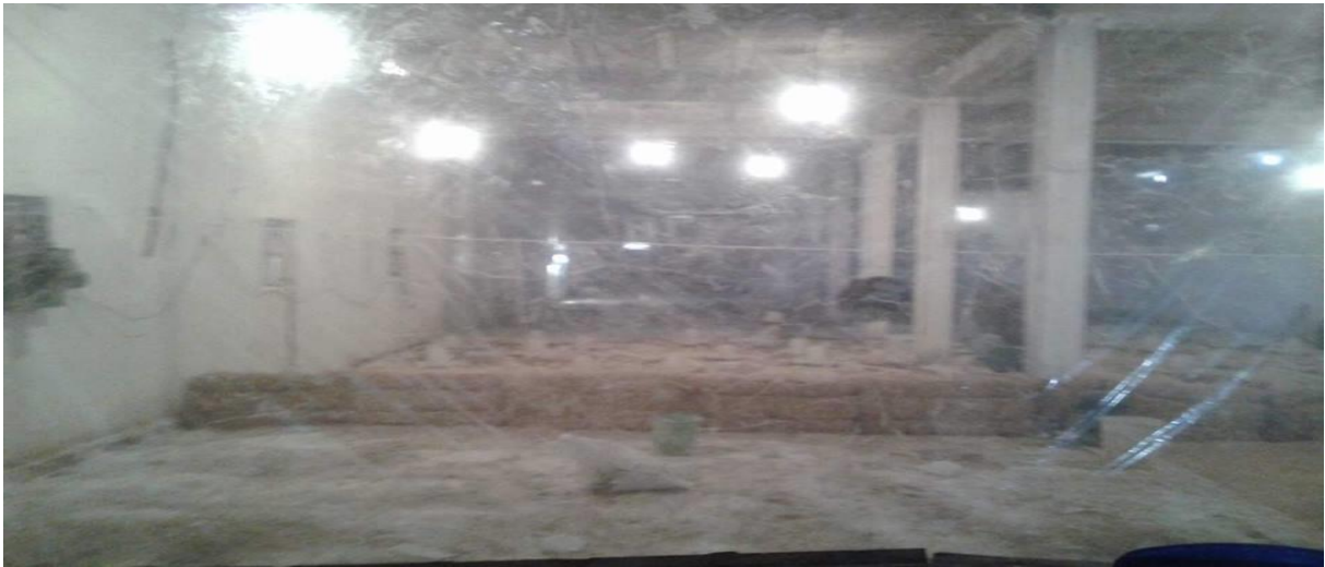
Figure 33 : Séparation du bâtiment en deux parties au moyen d'une bâche (photo personnel).
