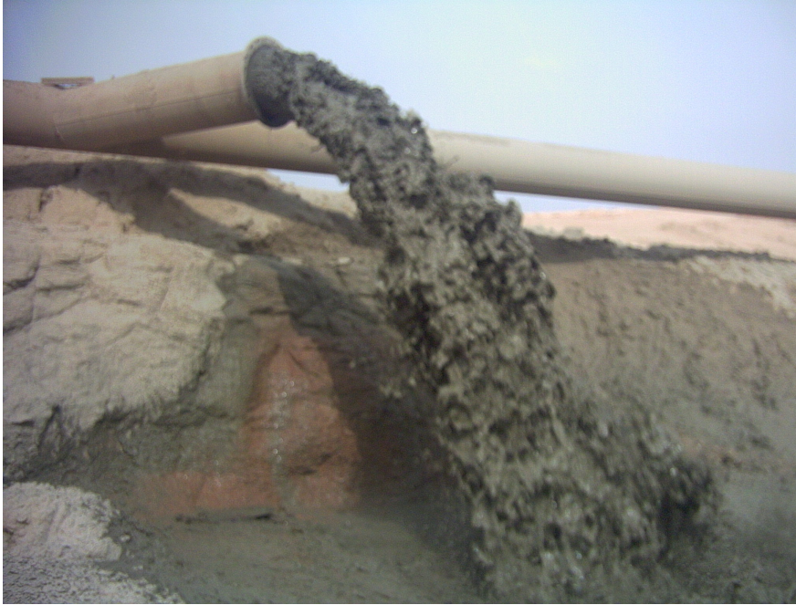
Fig. 3.16. Rejet de la vase lors de l'opération de dragage de 2005-2006 (Remini, 2006)
