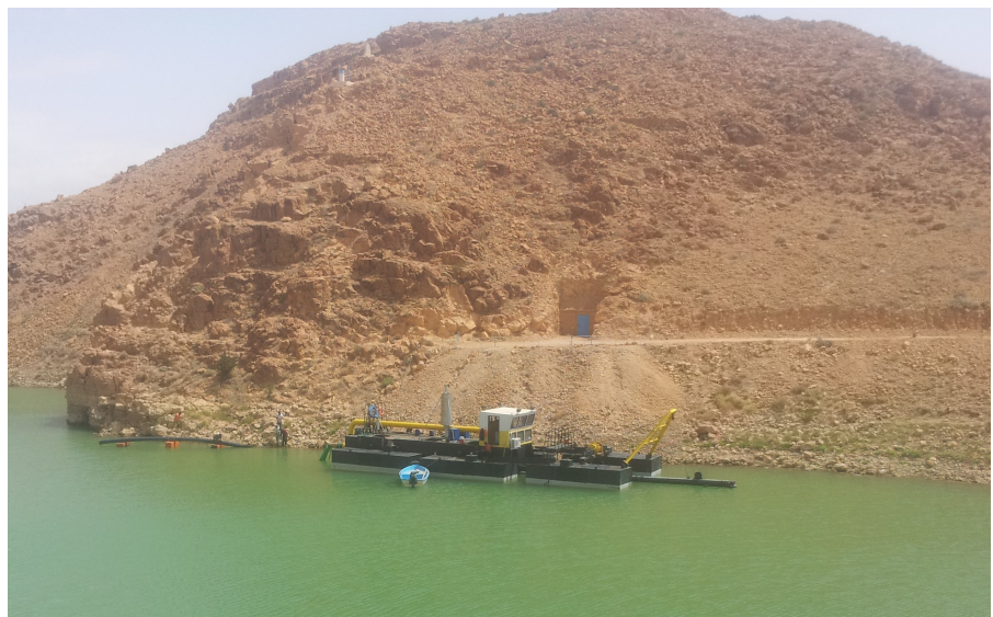
Fig. 3.18. Installation de la drague pour une deuxième opération de dragage
