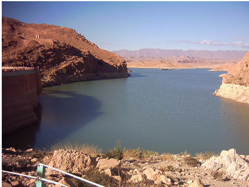
Fig. 1.5. Vue générale du barrage de Fom El Gherza (Remini, 2004)
