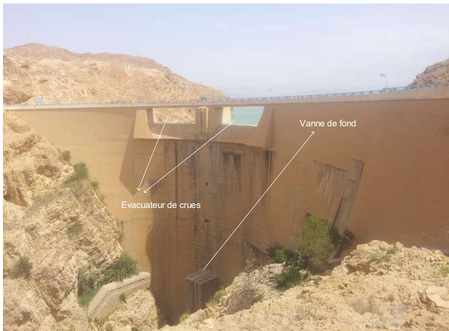
a) Vanne de fond- Vue de la rive gauche (Maazouz, 2015)
