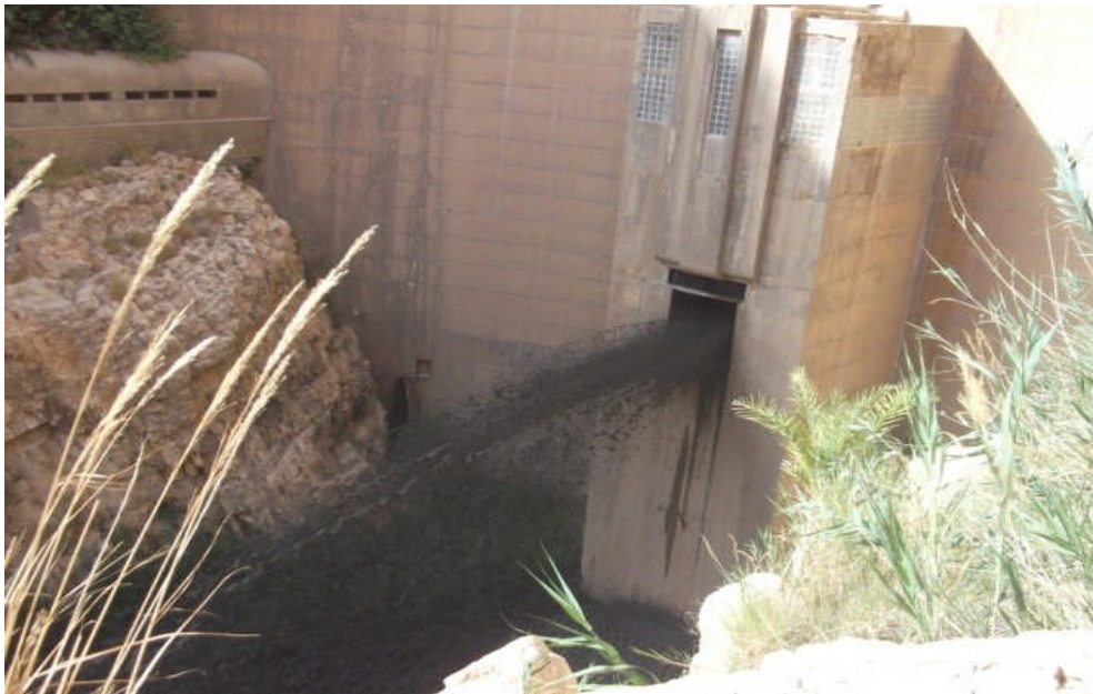
Fig. 3.6. Evacuation de la suspension vaseuse (Cliché ANBT, Biskra)
