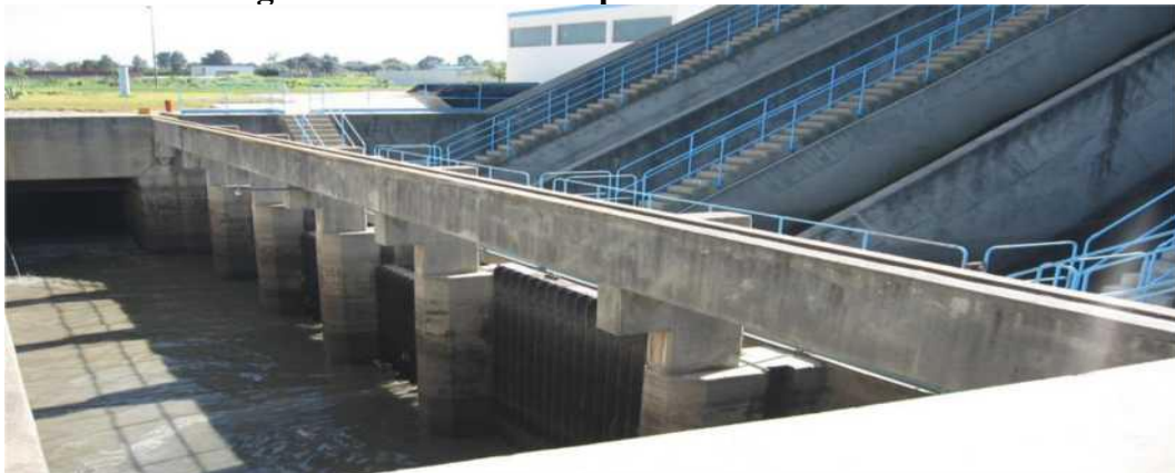
Figure V.2 : Emplacement des grilles grossières
