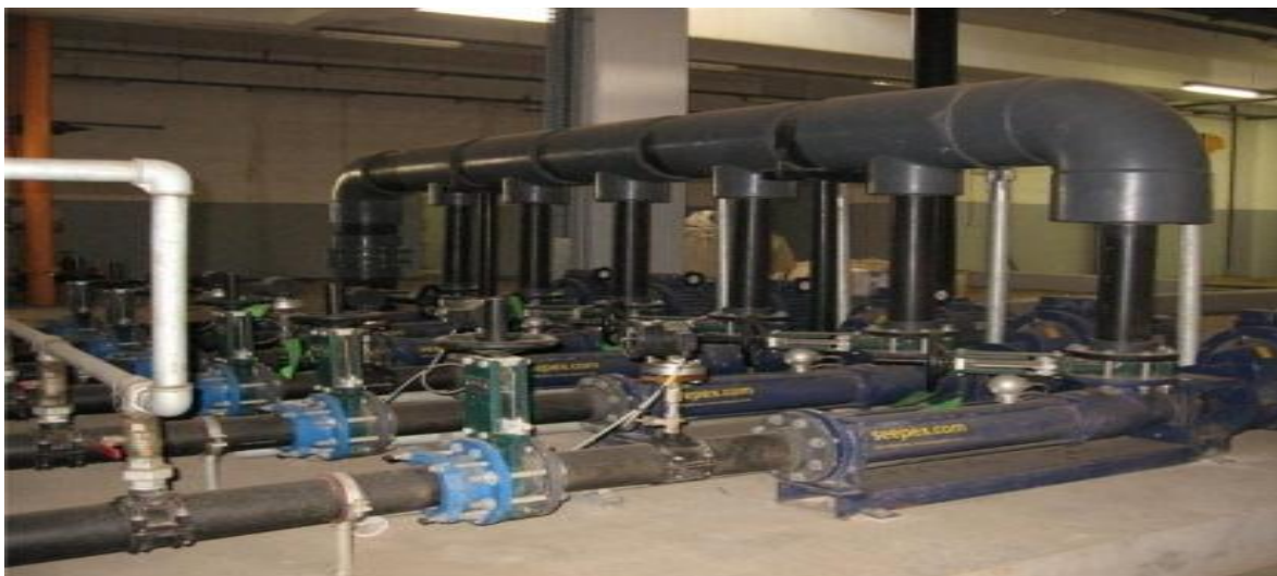
Figure V.23 : Les pompes à boues
