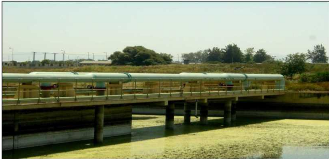
Figure IV.27:Etat du bassin d'aération
