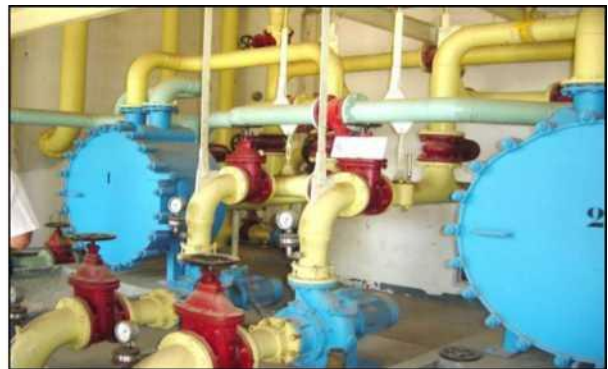
Figure IV.34: Échangeurs thermiques
