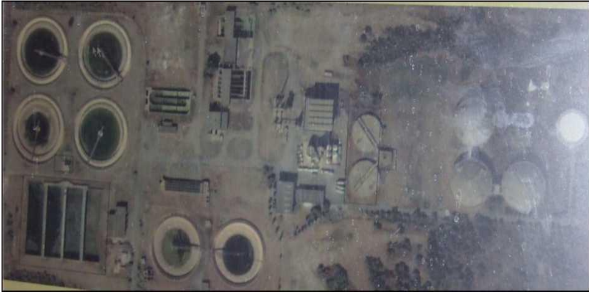
Figure IV.1: Vue de haut de la station endommagée et à l'arrêt
