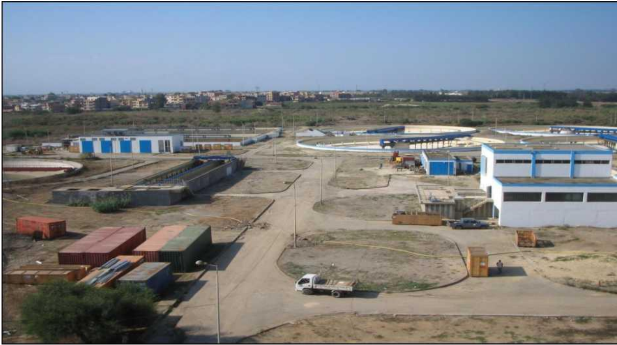
Figure IV.45: Vue d'ensemble de la step de Baraki
