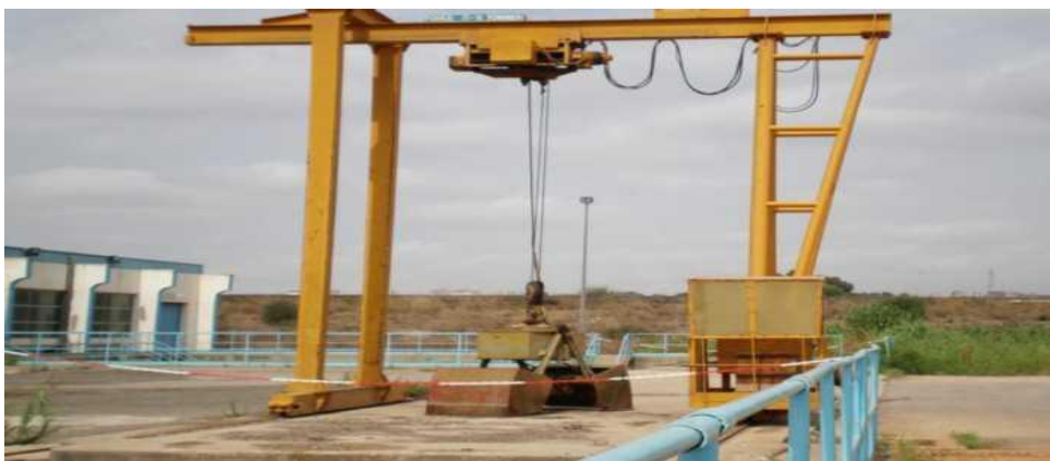
Figure V-3 : La réhabilitation du portique
