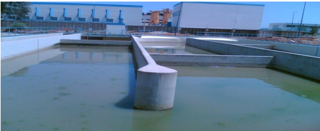
Photo III.7 : Bassin de chloration.
