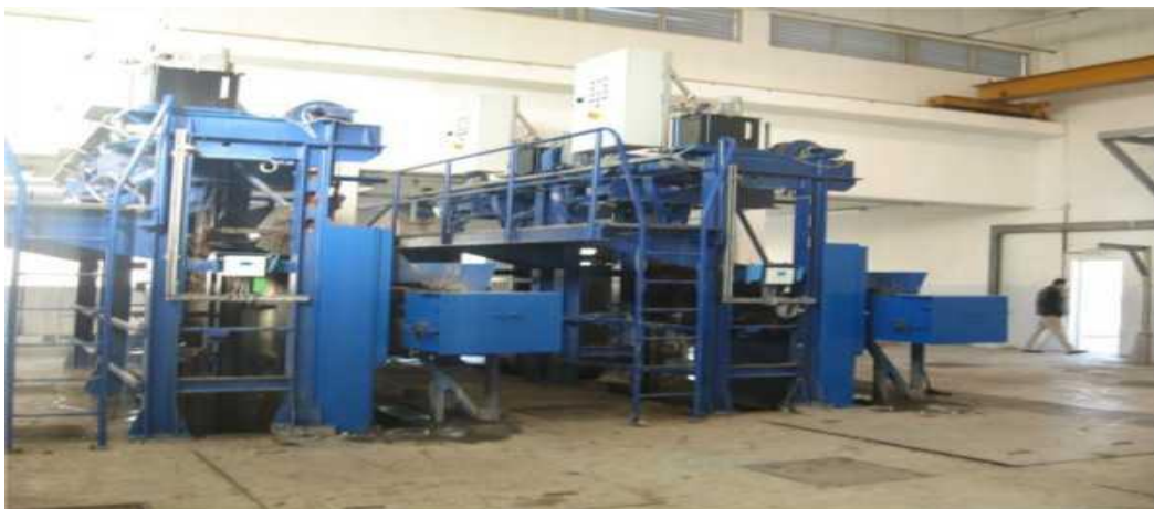
Figure V-4 : Etat du dégrillage après la réhabilitation
