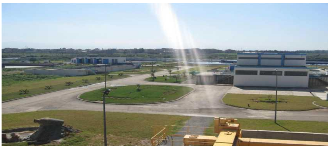
Figure V.31 : Vue d'ensemble de la station réhabilitée
