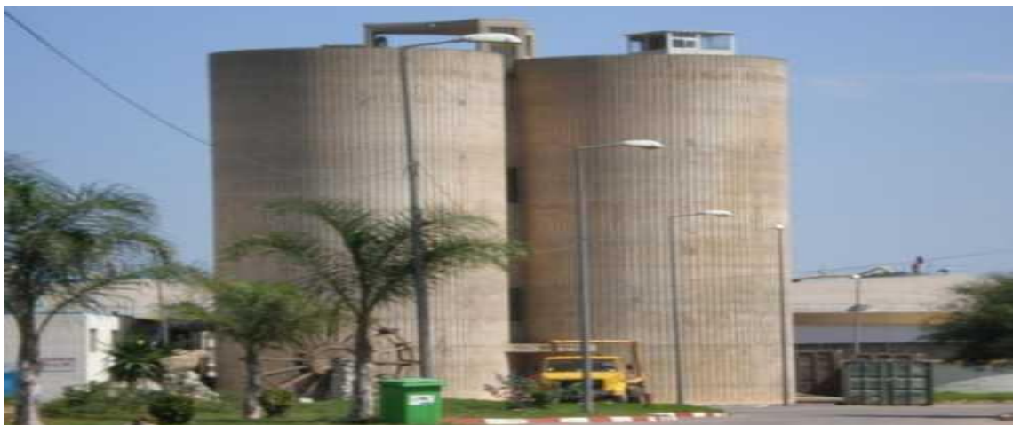
Figure V.27 : Silo à chaux
