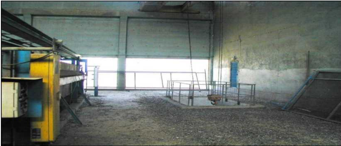
Figure IV.13 : Bâtiment de déshydrations
