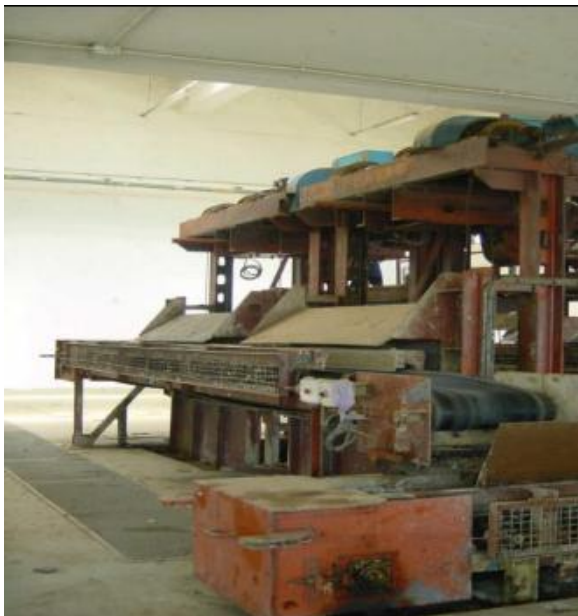
Figure IV.20 : Poste de dégrillageBandes (Transporteuses d'évacuation des refus)
