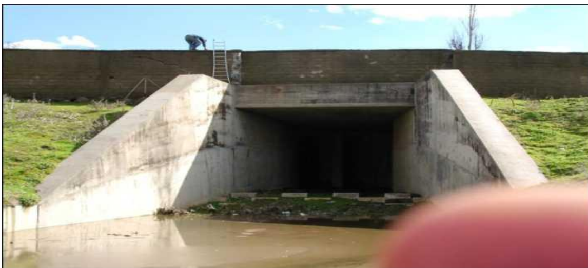
Figure IV.10 : Ouvrage de rejet
