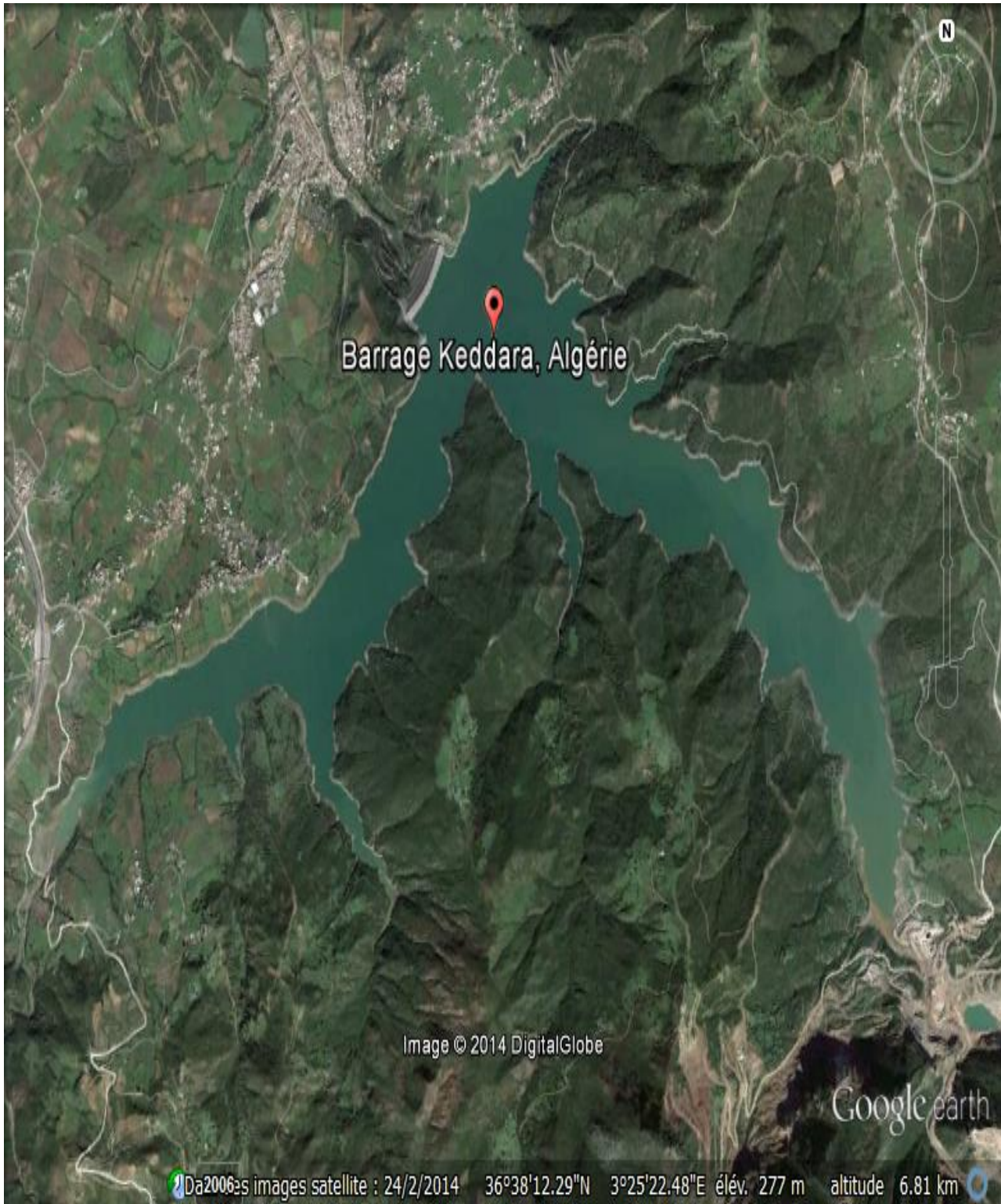
Figure I-1: Image satellitaire du barrage KEDDARA. [2]
