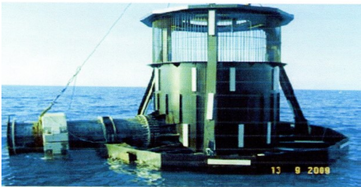
photo 3-2: Tête de prise d'eau et grille d'aspiration sources.
