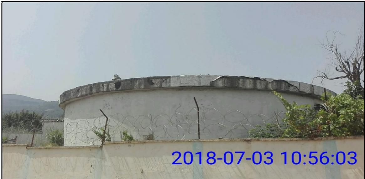
**Figure (III.4) :** Vue extérieur de réservoir semi enterré RV1000 m<sup>3</sup>.
