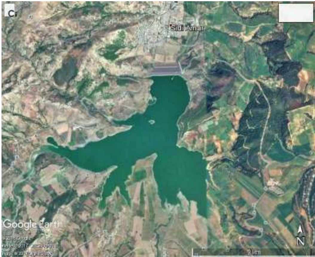
Fig.II.1. Localisation du barrage Boukourdane (Google Earth).
