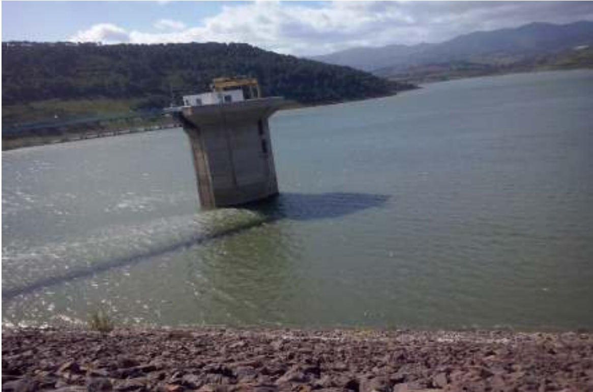
Fig.II.5. Tour de prise d'eau du barrage (Photo prise pendant la sortie, avril 2018).
