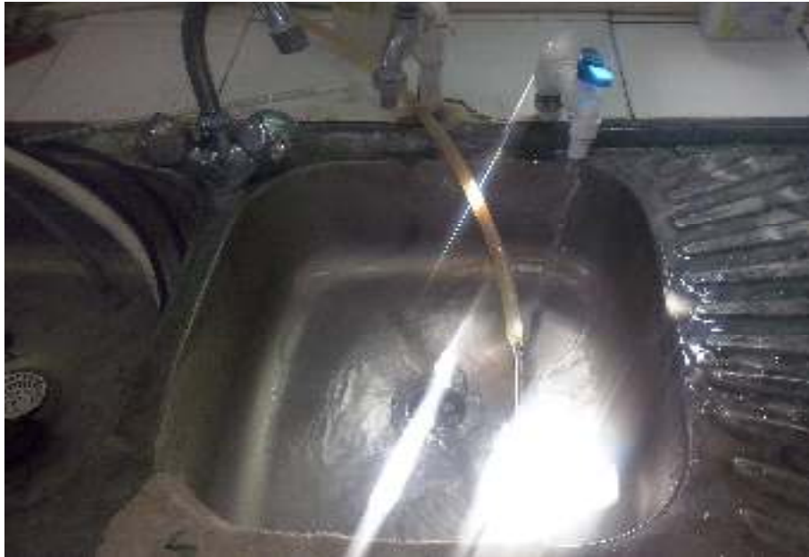
Fig.III.11. Prélèvement au niveau de Robinet de laboratoire.
