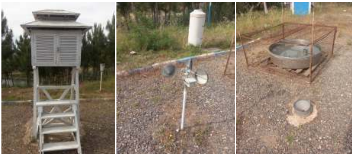
Fig.II.7. Station météorologique du barrage Boukourdane).
