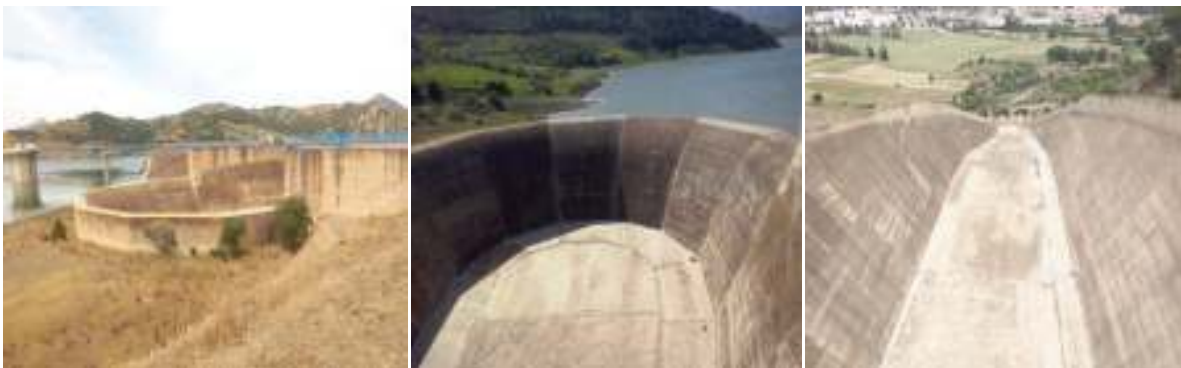
Fig.II.6. Evacuateur de crue du barrage Boukourdane.
