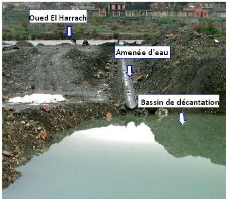
Figure 9 : Amenée d'eau et bassin de décantation
