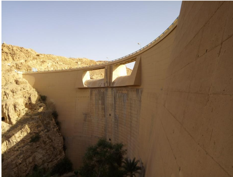
Fig. 3.16. Une vue générale de l'évacuateur de crues du barrage de Fom El Gherza d'un débit d'évacuation de 730 m 3 /s (photo. Mai 2017)
