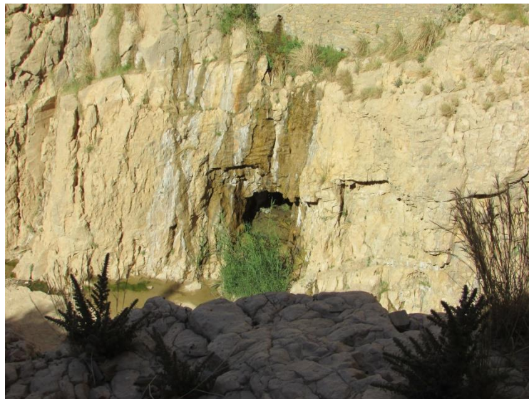
Fig. 3.3. Ruissèlement des eaux de fuites sur le massif de la rive droite du barrage de Foum El Gherza (photo. 2005)
