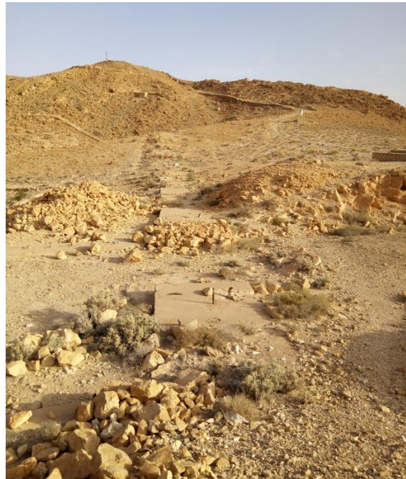
Fig. 3.9. Traces du rideau d'étanchéité sur la rive droite du barrage (photo. Mai 2017)
