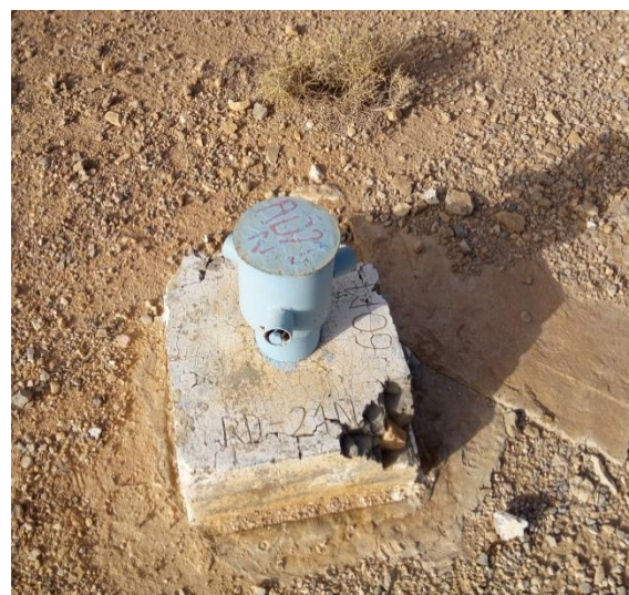
Fig. 3.11. Piézomètre fonctionnel de la rive droite RD 21N (photo. Mai 2017)
