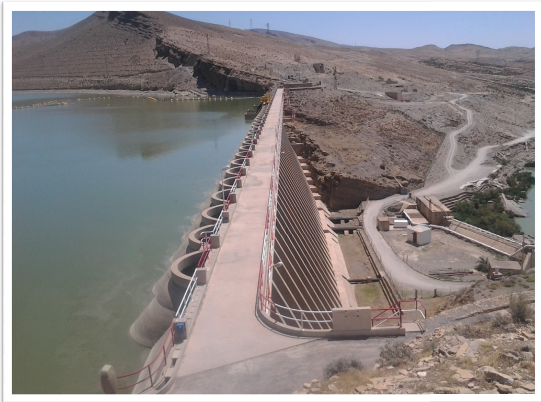
Figure 08 : la digue du barrage K'sob
