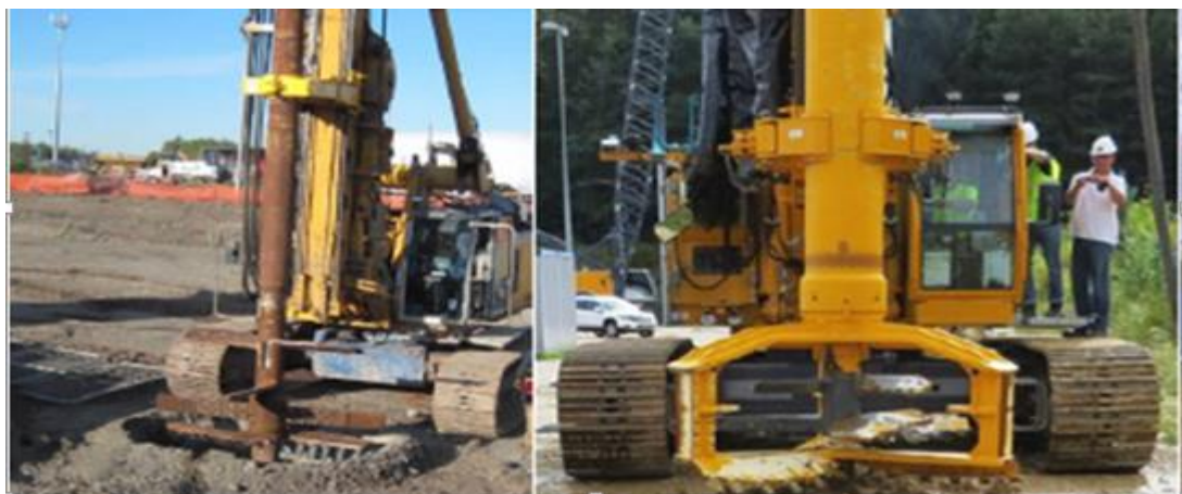
Figure 1. 6: Soil mixing par voie humide.
