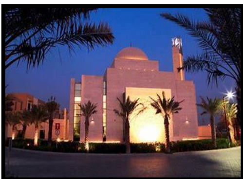
Figure 27 : La mosquée ; Source : the sustainablecity.ae
