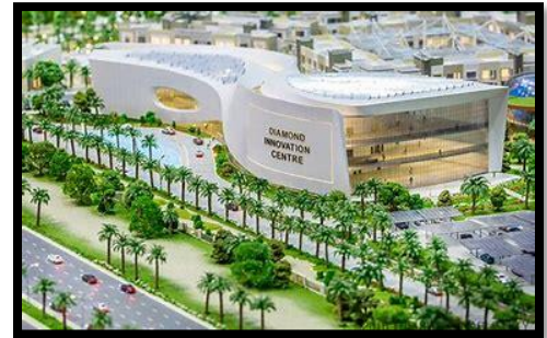
Figure 23 : Centre de recherches et d'innovation ; source : the sustainablecity.ae
