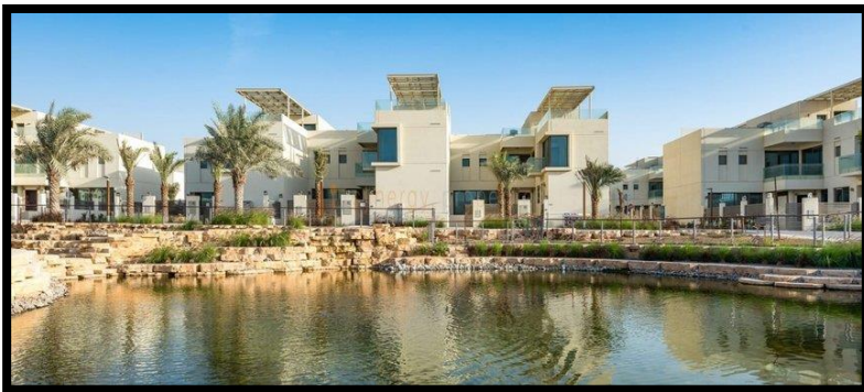
Figure 21: Les villas du projet ; source: the sustainablecity.ae
