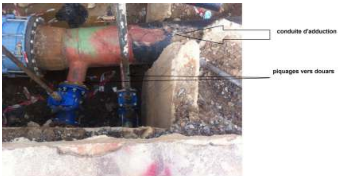
Photo.2 : conduite d'adduction actuelle
