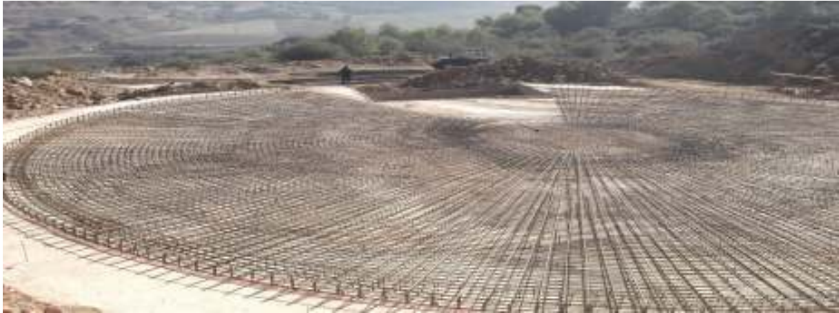
Figure III.6 : Plateforme du réservoir de 3000 m 3 au chef lieu
