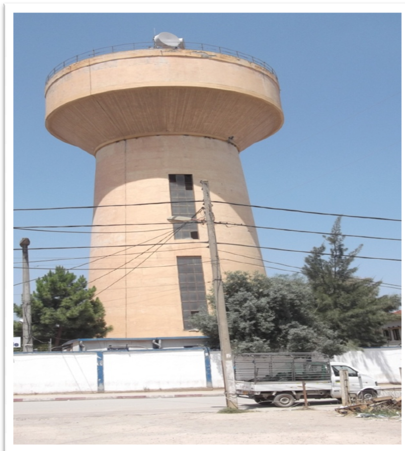
Figure III.1 : Réservoir 1200m 3 du chef lieu
