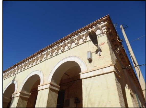
Photo 10. Traitement la façade (février 2018). Source : photo par l'auteur
