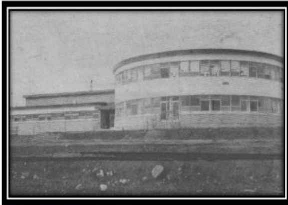
Figure 8 Le bâtiment en 1967
