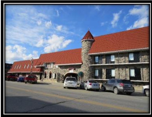
Figure 20 Le bâtiment en 2016
