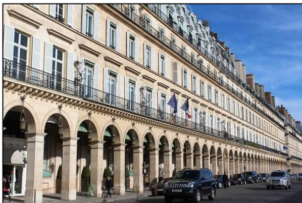
Photo 07. Vue rue de Rivoli à France Source : Fiche technique ; Courant et style architecturaux
