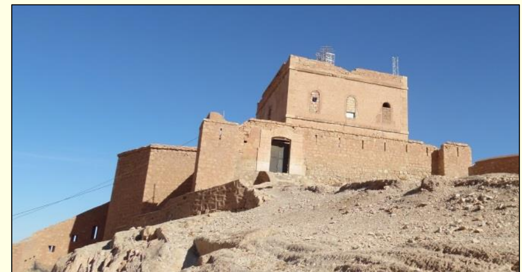
Photo N°19 : fort Morand 2018 source : auteur
