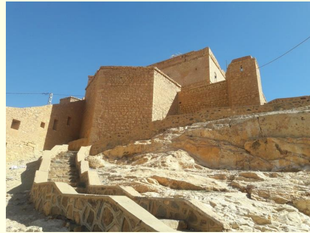
Photo N° 22 : fort Morand 2018 source : auteur
