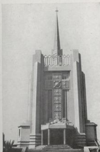
Sur les plans de MM. Garnier et Vasselon, Architectes à Alger, l'Archevêché a fait édifier cette église moderne, à ossature de béton armé en commémoration du débarquement des soldats du Maréchal de Bourmont, en juin 1830.
