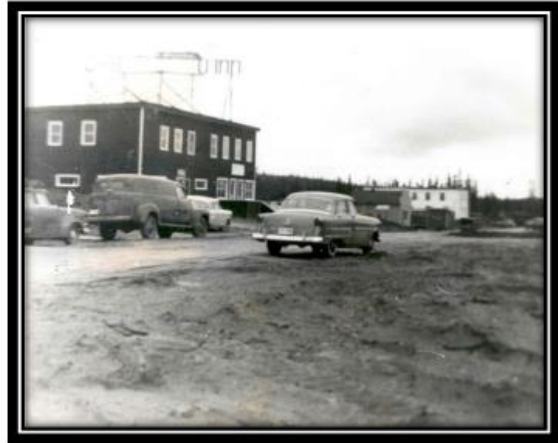
Figure 21 Le bâtiment dans les années 1950
