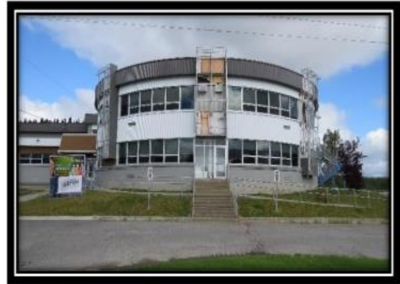
Figure 9 Le bâtiment en 2016
