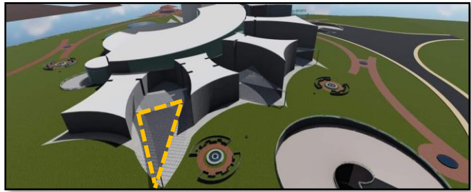
Figure 93 : Vue en 3D de la couverture métallo-textile
