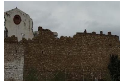
Figure 23 : Un mur en pierre en court de démolition source photo prise par l'autrice
