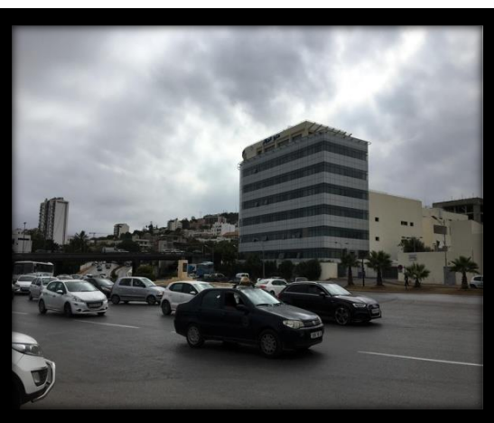
Figure 29 : Image montrant un équipement administratif source : photo prise par l'autrice
