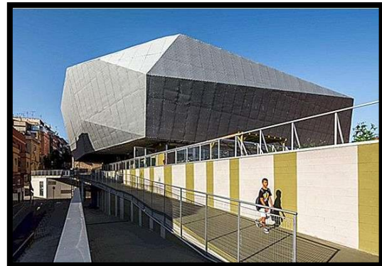
Vue extérieur du projet
