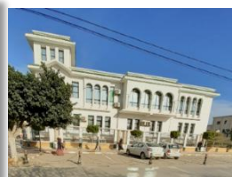
Fig.3.36 : la daïra en bon état
