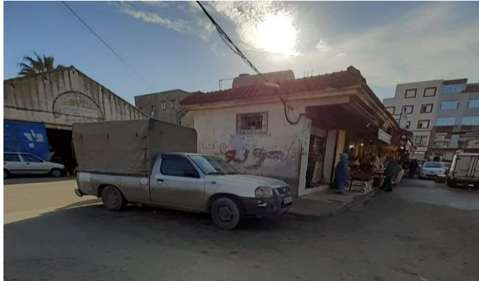
Figure 3.60: bonde de commerce en mauvaise état Source : prise par auteur
