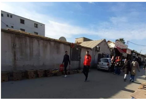
Figure 3.56: la braderie en mauvaise état
