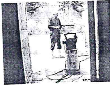
Figure 6 : nettoyage par cachère.
