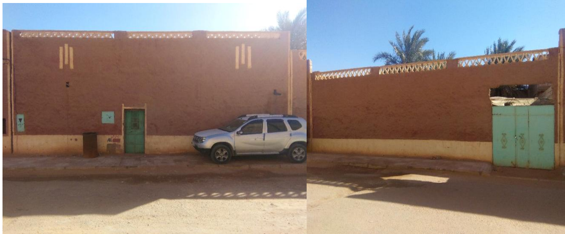
Figure 2.10 : la façade principale. Source (auteur).
