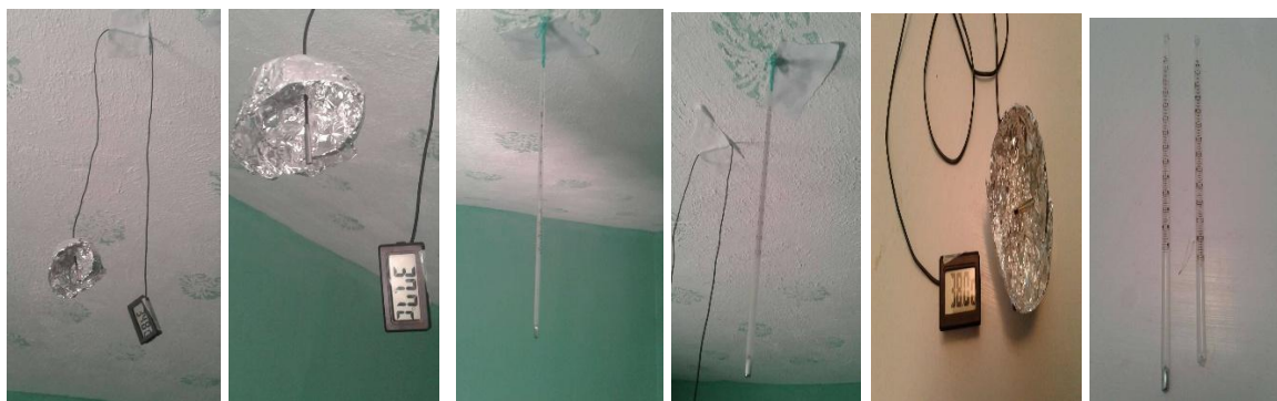
Figure 2.12 : installation des instruments de mesures.
