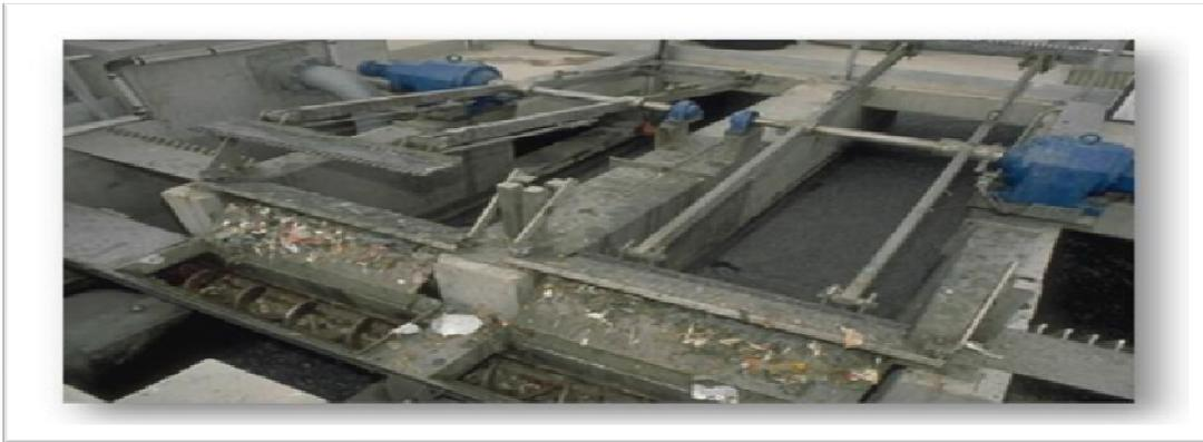
**Figure IV.1** : Dégrillage
