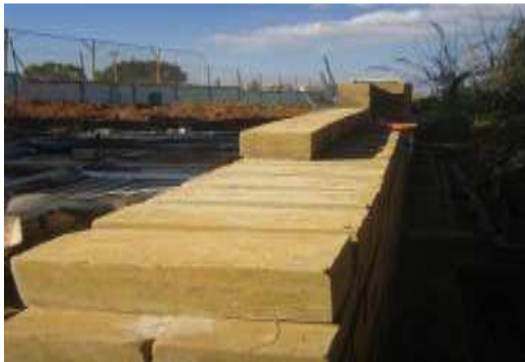
Figure 2.11 : Mur interne (Un panneau de BTS)
