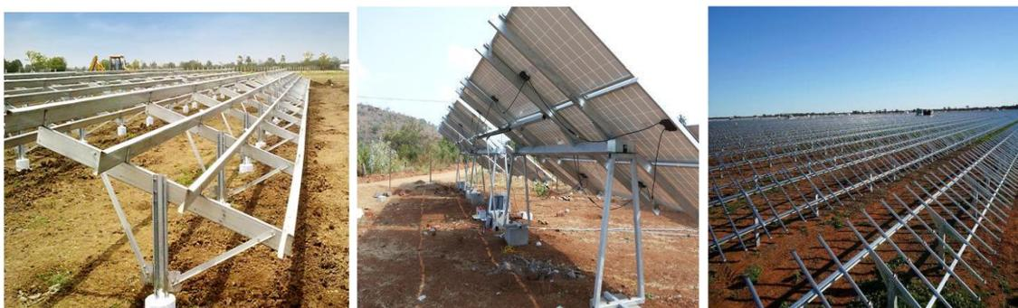
Figure I. 4 Exemples de structures porteuses.
