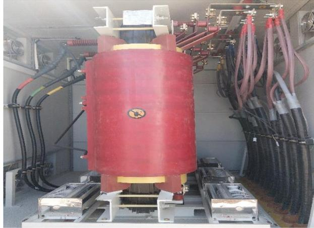
Figure I. 10 Transformateur de la centrale PV de Djelfa.
