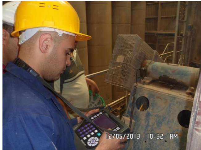
Photo 4.4 Enregistrement des mesures de vibrations du ventilateur
